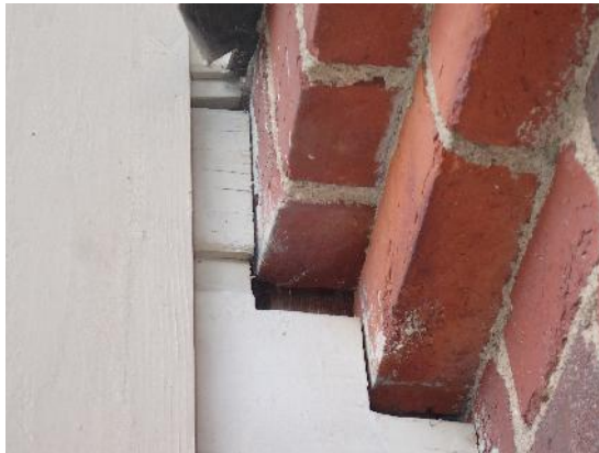
Kuvat 21 ja 22. Eteisen 102 ja tuulikaapin ulkoseinien liittymät ovat eläneet runsaasti.
