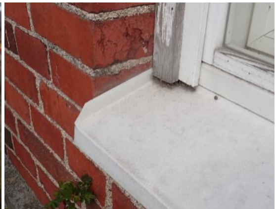
Kuvat 23 ja 24. Ikkunapellitykset on asennettu siten, että ne mahdollistavat pieliä vasten valuvan veden kulkeutumisen seinärakenteisiin.
