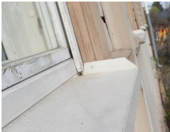
Kuvat 23 ja 24. Ikkunapellitykset on asennettu siten, että ne mahdollistavat pieliä vasten valuvan veden kulkeutumisen seinärakenteisiin.
