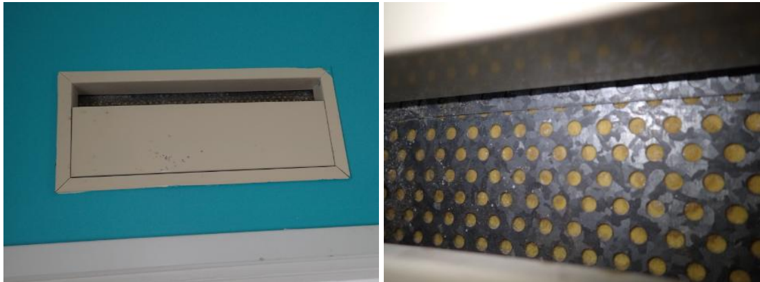
Kuvat 52 ja 53. Siirtoilmasäleikköihin on asennettu mineraalivillaa.
