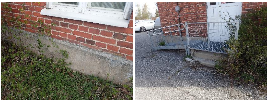
Kuvat 4 ja 5. Uudemman osan sokkelin rakenne ei varmuudella selvinnyt. Lounaispäädyyn on rakennettu uusi kulkuluiska metallista.
