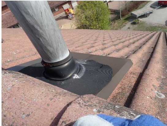
Kuva 51. Uusittu kattoläpivienti.
