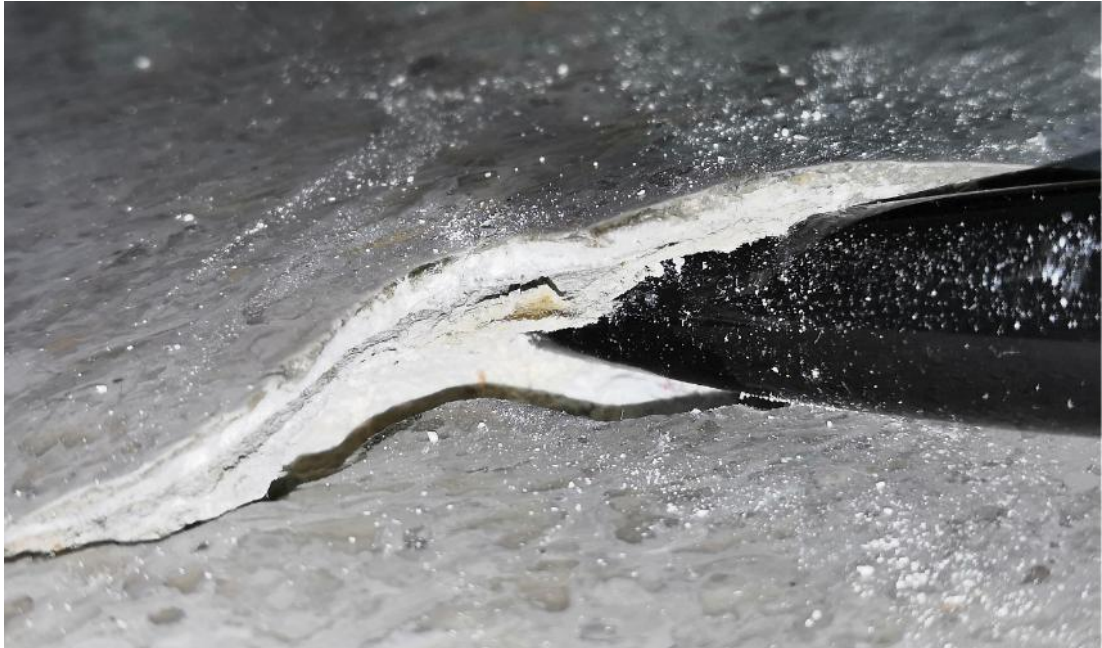
Kuva 16. Lattian muovimaton alla on kipsilevy.
